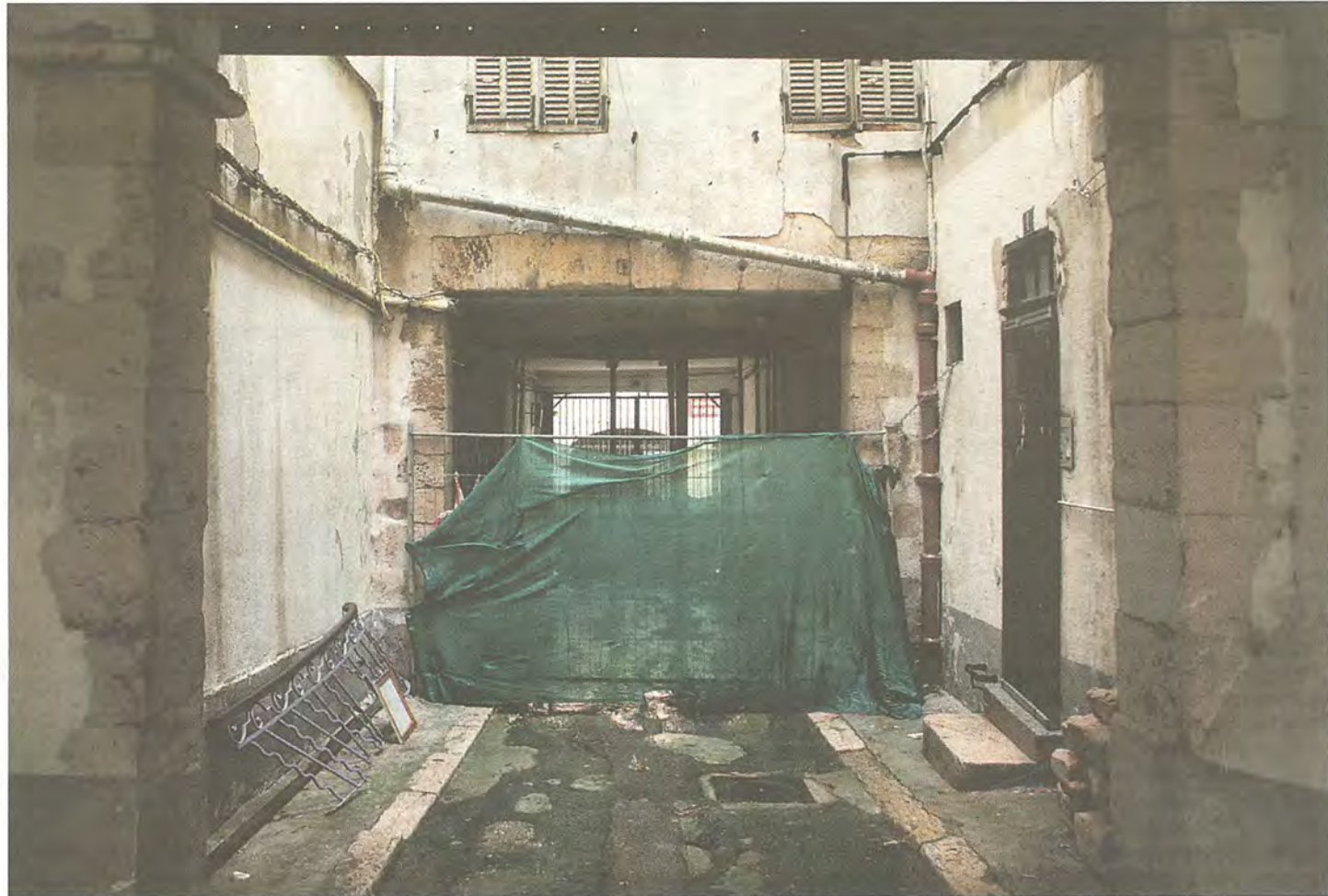
En face des numéros 64-65-67 de la rue d'Aubagne, le 6 novembre, au lendemain de l'effondrement de deux immeubles.
