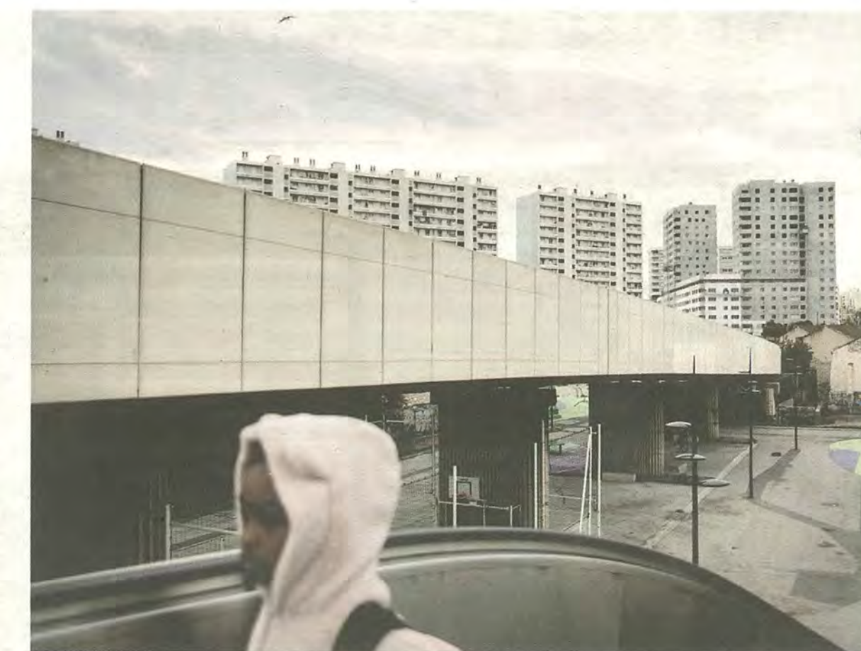
Près du Parc Bellevue, les nouveaux bâtiments font face à l'ancienne cité HLM.
