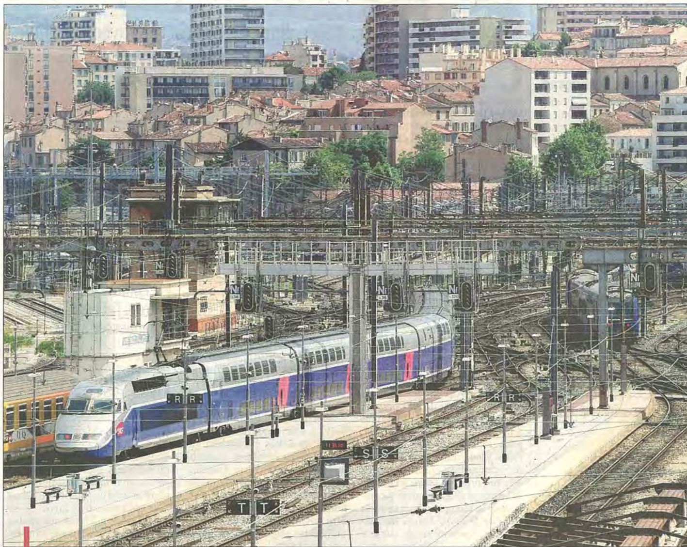
Avant les travaux en souterrain, les premiers coups de pioche concernent l'aménagement des voies en surface.
