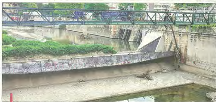
Lors des épisodes orageux, la vanne barrage est abaissée et l'Huveaune retrouve son cours naturel. Sa pollution endémique et les déchets flottants sont charriés jusqu'aux plages. Par conséquent, celles qui sont à l'embouchure du fleuve sont fermées. / PHOTO GEORGES ROBERT
