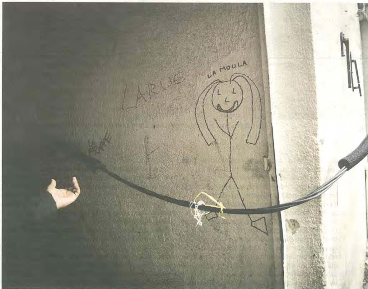
De nombreuses installations électriques ne sont toujours pas aux normes à Maison Blanche.
