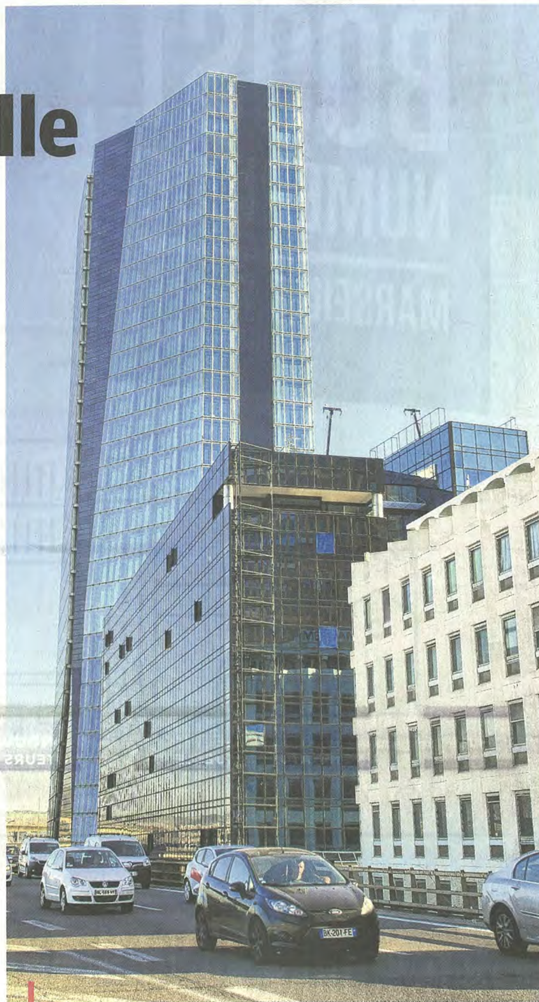
Une vue des trois sièges sociaux de la CMA CGM, dont la fameuse tour qui domine la ville à 147 mètres de hauteur, qui illustrent l'ascension du groupe à Marseille et dans le monde.
