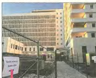
Des grillages entre deux chantiers et au bout, la flamboyante école Allar.
